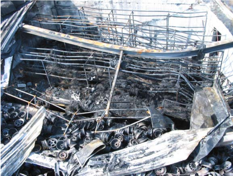
Die Deformierung des Doppel-T-Stahlträger zeigt, welche enorme Wärme bei Reifenbränden entsteht.
